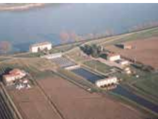
Impianto Idrovoro di derivazione irrigua Sabbioncello
