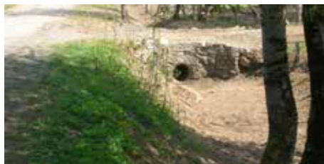
Pulizia del tombino sottopassante la viabilità
