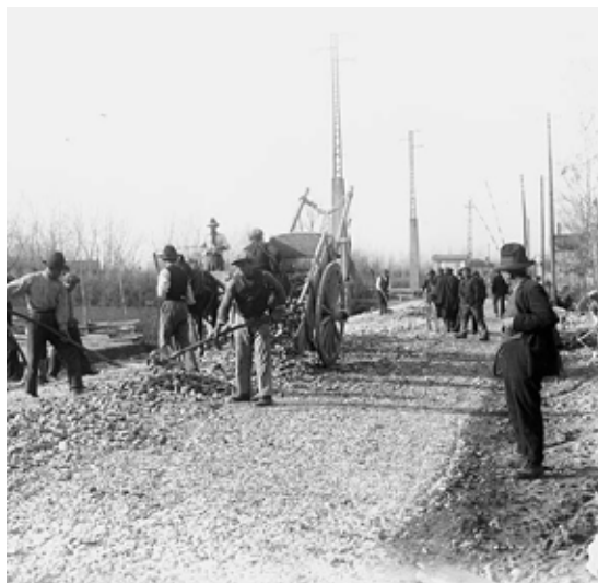
Costruzione di strade a seguito della bonifica delle terre
