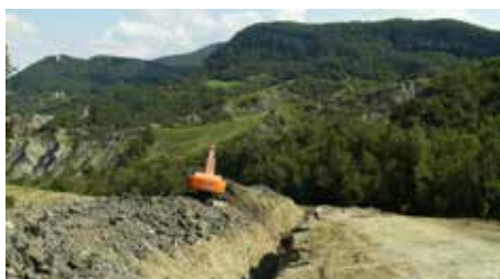
Esecuzione di drenaggio
