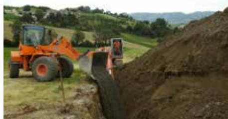
Esecuzione di drenaggio
