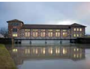
Impianto Idrovoro Bondeno-Palata
