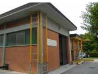
Impianto Pluvirriguo Concordia Sud
