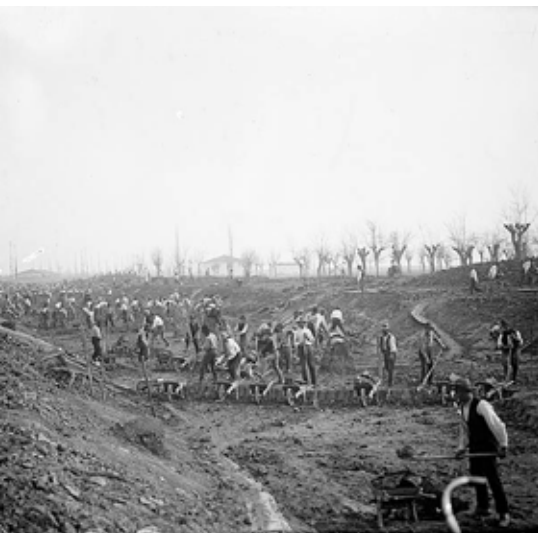
Scavo di un canale di bonifica da parte di scarriolanti
