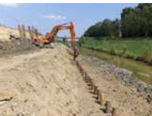
Palificazione per sistemazione frana
