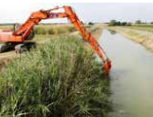
Pulizia di un canale
