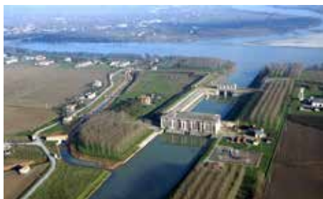
Impianto Idrovoro Pilastresi
