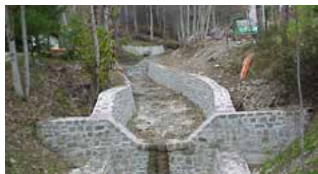
Sistemazione in pietrame di un corso d'acqua minore
