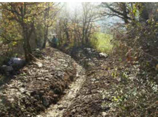
Esecuzione di affossatura
