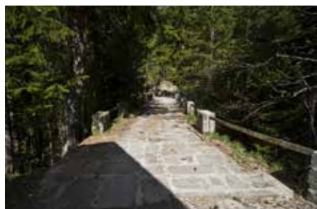
Sistemazione di viabilità minore
