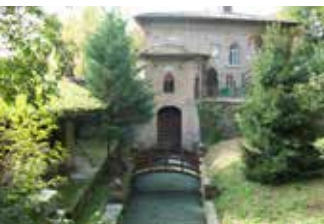
Presa Canale San Pietro
