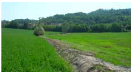
Fosso per regimazione superficiale
