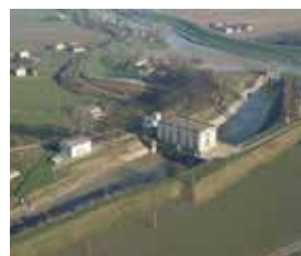
Impianto Idrovoro Santa Bianca
