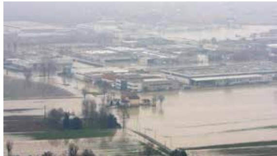
Alluvione in pianura
