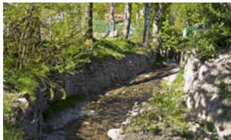
Sistemazione spondale in pietrame
