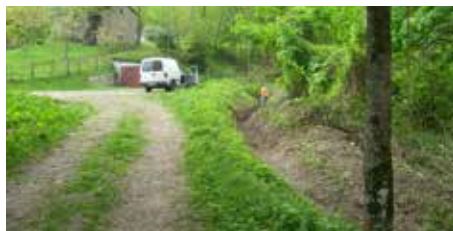
Manutenzione di un fosso vicino alla viabilità
