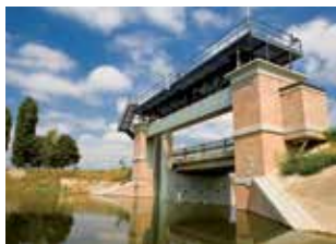
Paratoia Guazzaloca trattiene l'acqua del Canale Emiliano Romagnolo
