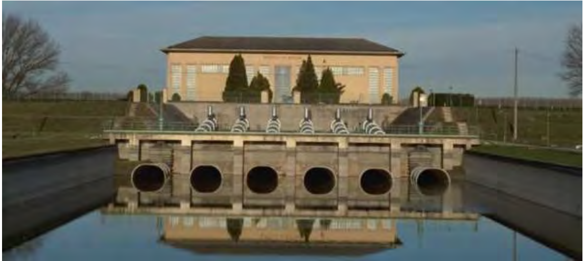
Figura 4.42: Immagine dell'impianto Sabbiuncello (fonte: Consorzio di Bonifica della Burana).
