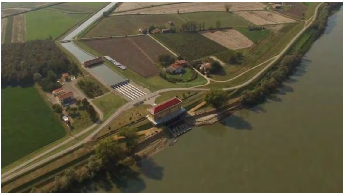
Figura 4.43: Vista dall'alto dell'impianto Sabbiuncello (fonte: Consorzio della Bonifica Burana).
