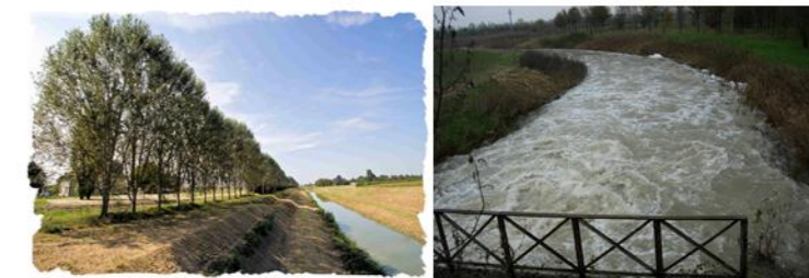
Canale Collettore Acque Basse
