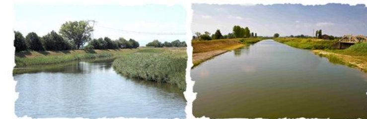
Canale Collettore Acque Alte, Crevalcore (Bo)
