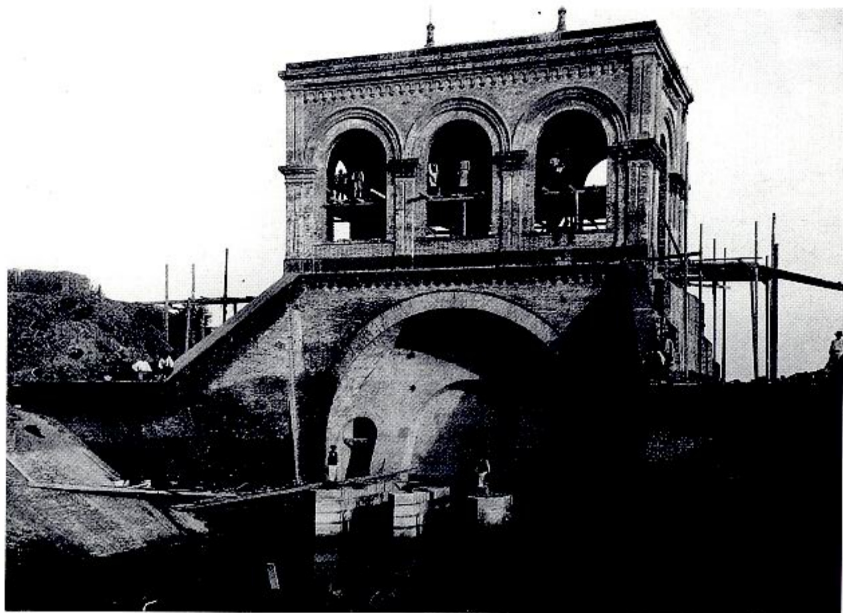
Controchiavica Pilastrese - Esecuzione delle murature.
