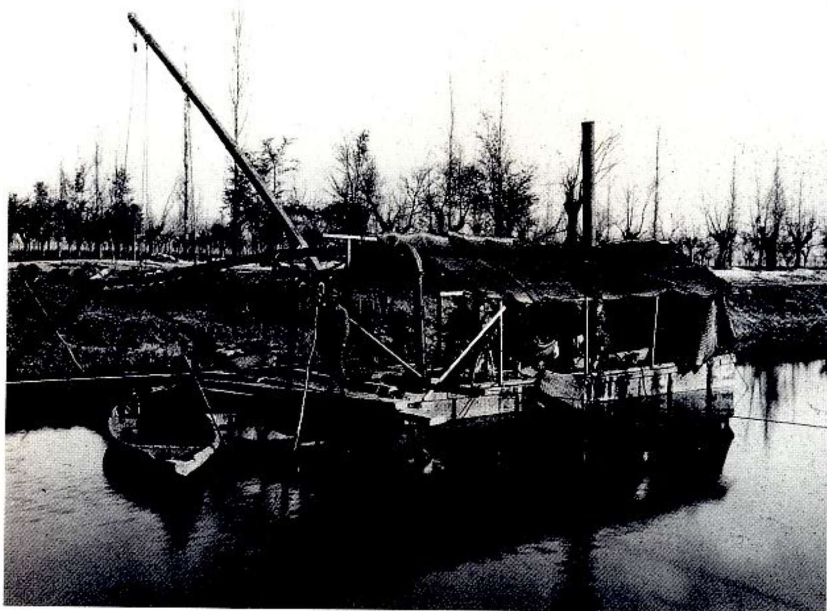
Escavo con pompa a sabbia nel tronco Bondeno-Ferrara.
