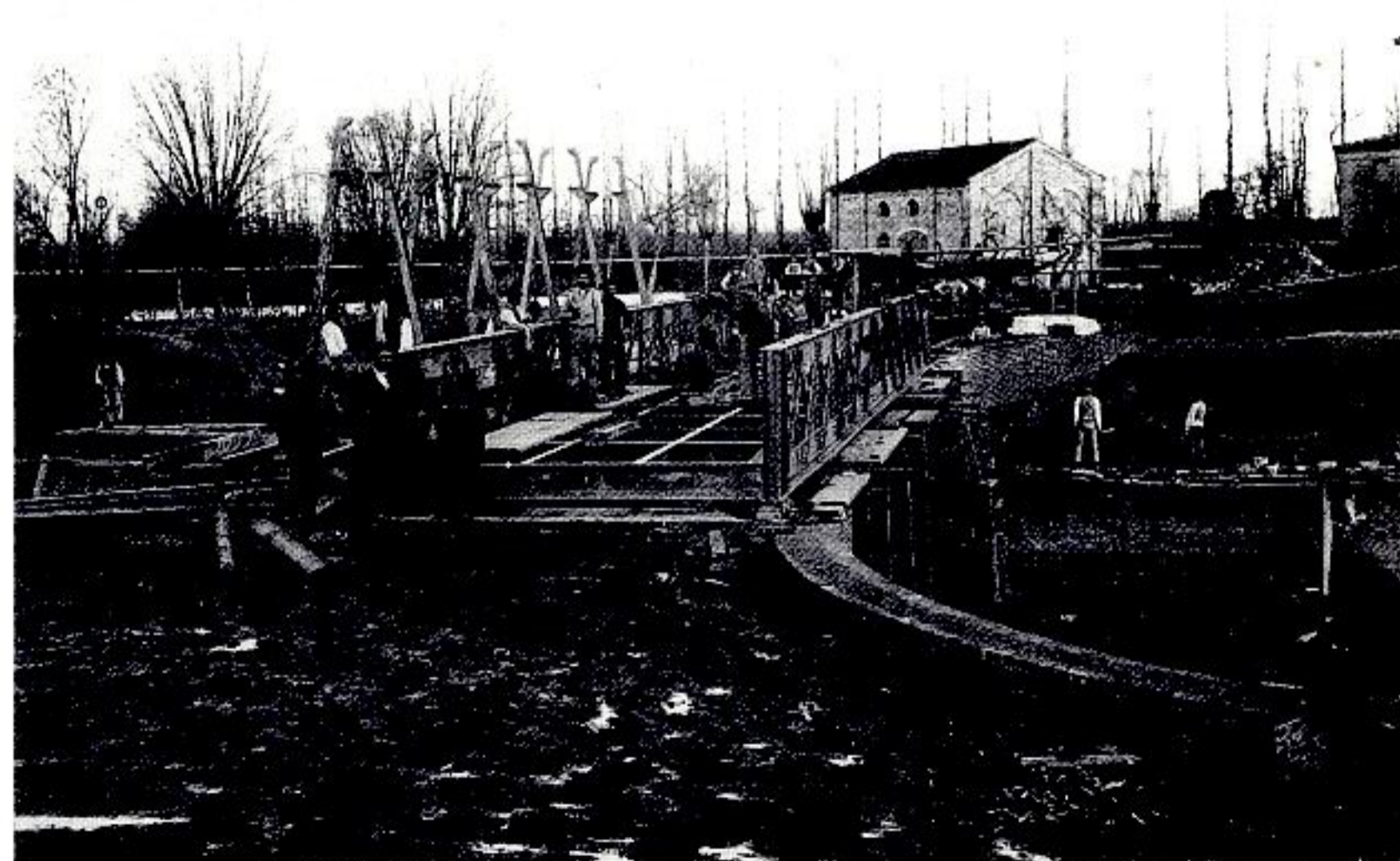
Sostegno di Valpigliaro. Montatura del ponte e chiusa mobile.
