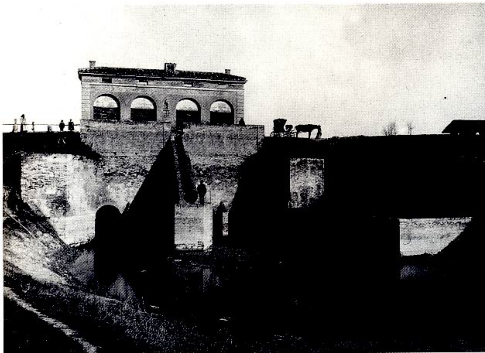
Chiavica Pilastrese costruita nel 1613.
