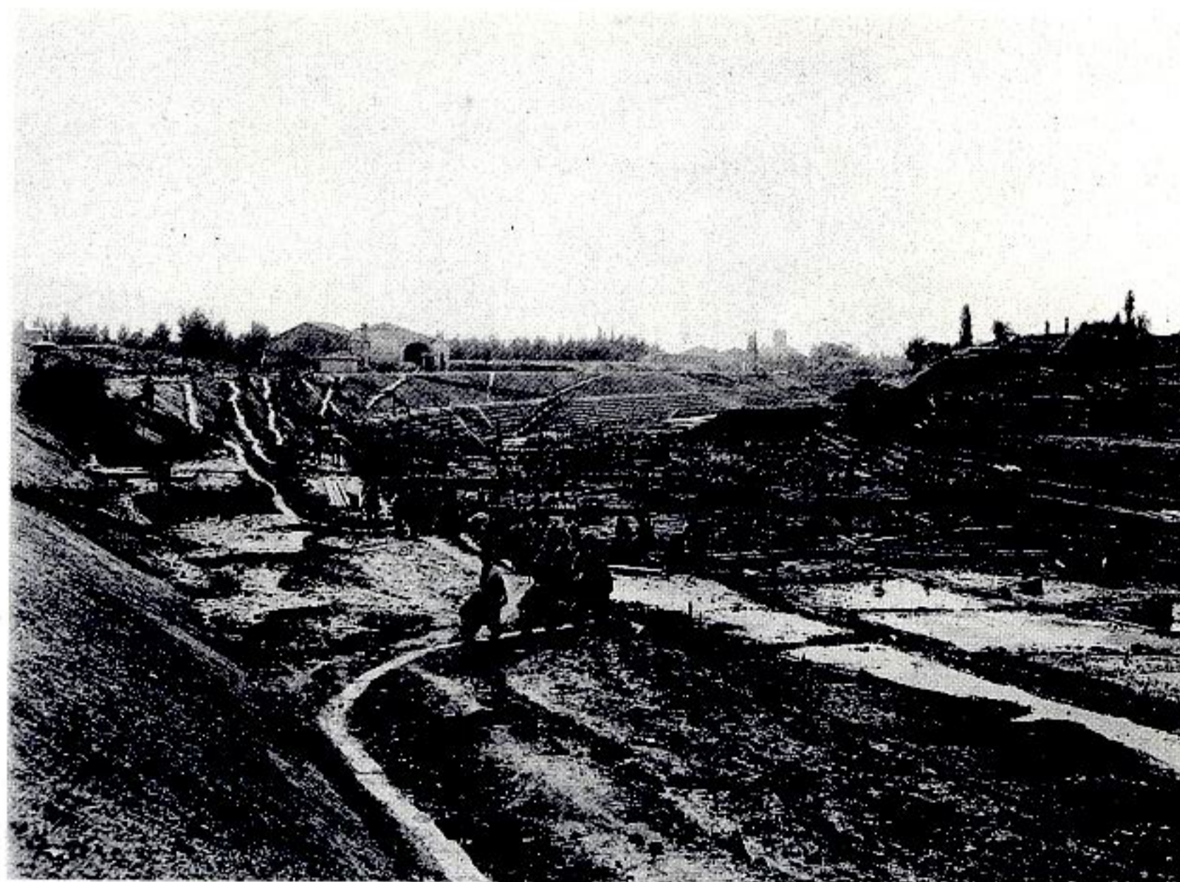
Ripristino di frane presso Bondeno.
