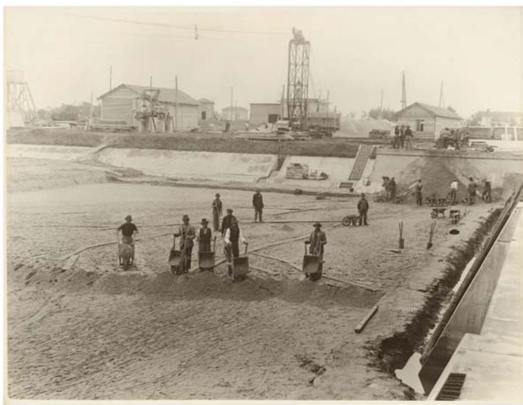
Scariolanti al lavoro per la costruzione dell'impianto delle Pilastresi Stellata di Bondeno (Fe), Anni '40
