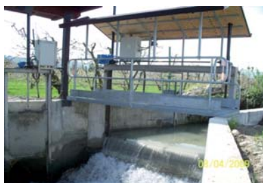
La paratoia di intercettazione delle acque del Canale di San Pietro
