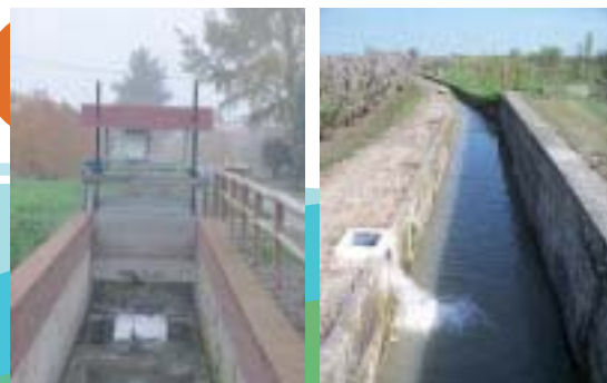
La paratoia di carico del micro bacino dell'impianto (foto a sinistra) e il punto di immissione delle acque del Canale San Pietro nel Canale Diamante (foto a destra).
