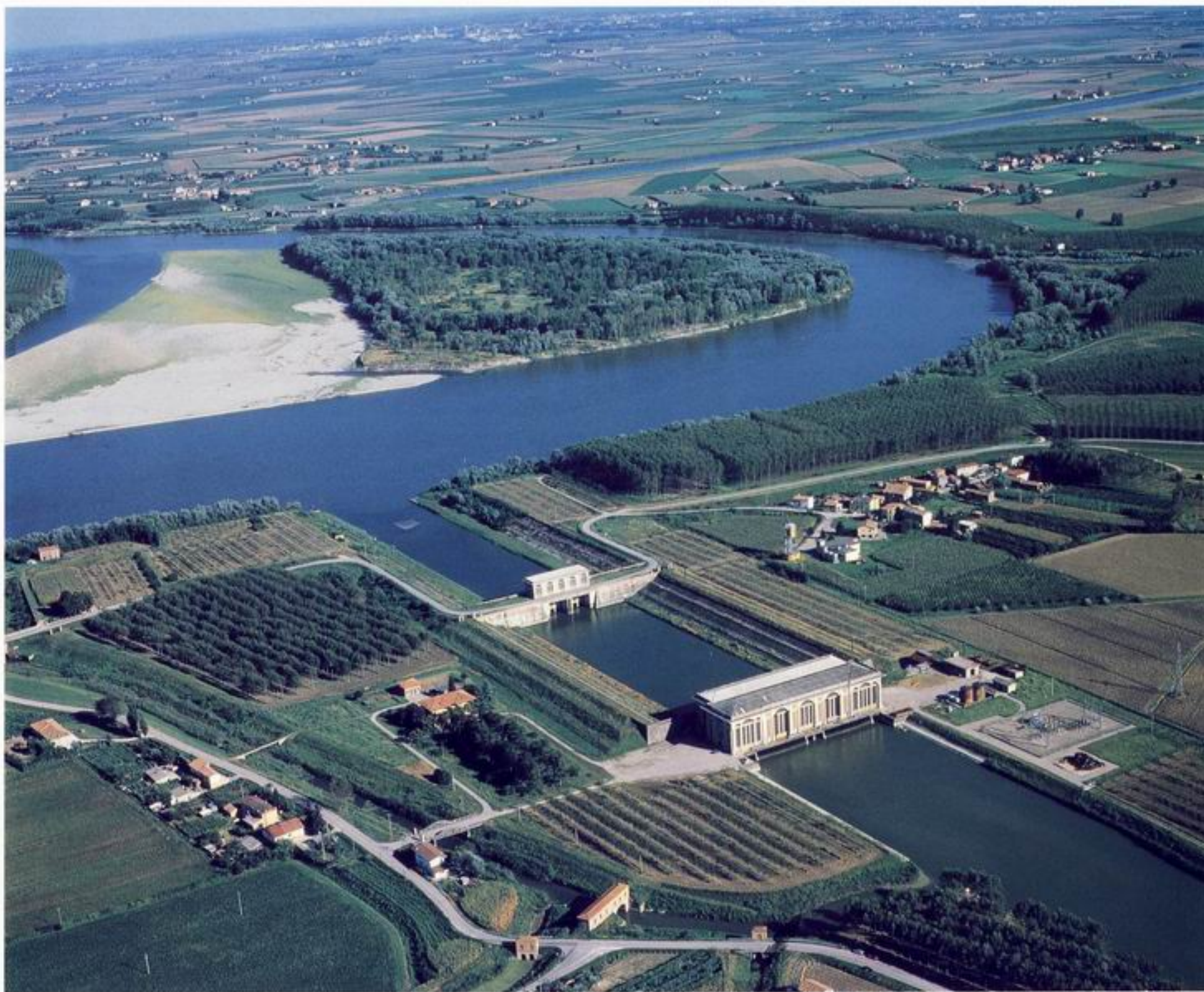
Questa foto dell'impianto Pilastresi risale a più di un decennio fa: da allora si è provveduto al suo ammodernamento con l'installazione di nuovi apparati tecnologici che gli conferiscono maggior sicurezza nel funzionamento (Archivio Cassa di Risparmio di Carpi, foto Parmiggiani).
