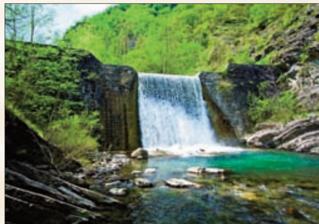
Briglia sul Torrente Dardagna, affluente del Panaro (Lizzano in Belvedere - BO)
