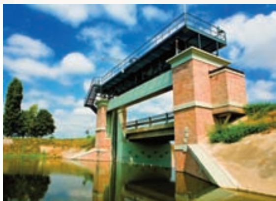
Paratoia Guazzaloca (Crevalcore - BO).
