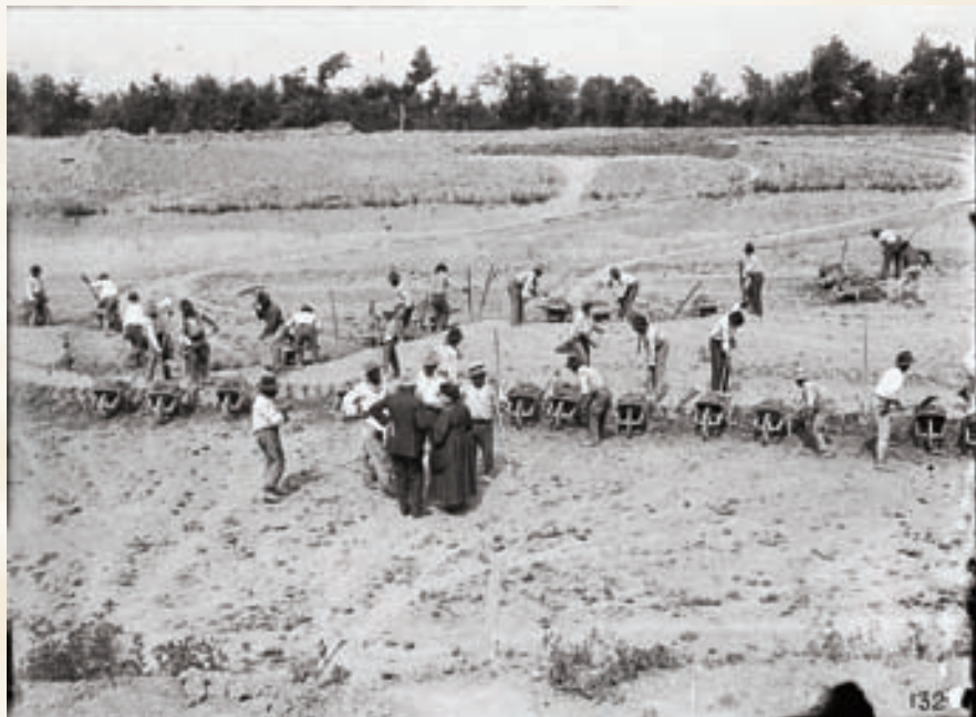
Lavori di escavo presso l'Emissario delle Acque Basse. Anni '20 - '30 del Novecento.
