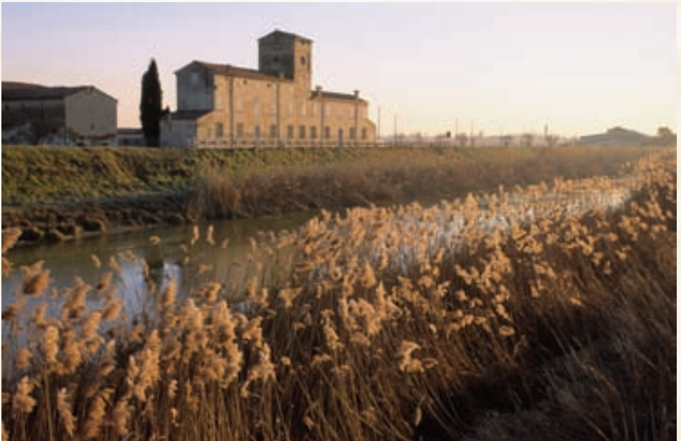
Canale Collettore di Burana, Bondeno (FE).
