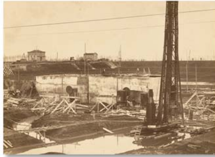
Costruzione dell'impianto Pilastresi, anni '30
